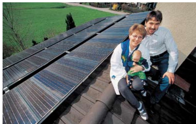
Familienfreundlich: Mit Solartechnik auf dem Dach spart man bei einem Einfamilienhaus jährlich rund CHF 600.-- an Energiekosten.
